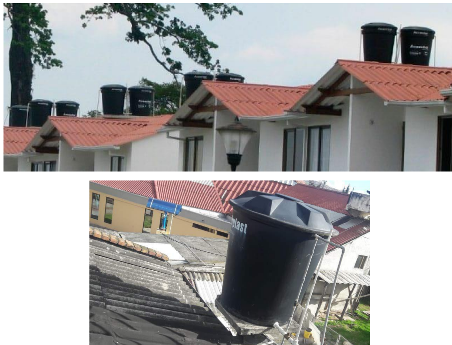
Figura 1. Imágenes representativas de la implementación de tanques elevados.
